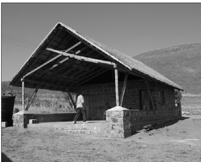
Le nouveau centre KaGogo de Mambatfweni
